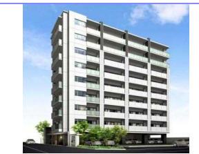
●平成24年2月第6ケイコーマンション駅南(福岡)竣工
